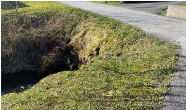
Bildet til v. vise eit eksempel på manglande sikring av sidearealet til ei vegbane – det er om lag 2 meter frå topp vegbane til botn på elveløp. Sikringa av elveløpet bør strekkast lengre frå vegbane slik at både kjøretøy, syklistar og gåande kan få ein meir skånsam stopp om uhell skulle oppstå. Føringskant, rist, eller forlenging av rørføring kan vere tiltak for å betre sikkerheita.
