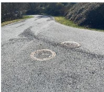
Bilde til v. vise strøsand som ikkje er rydda vekk etter vintersesongen. Strøsand i vegbana er som kulelager for syklistar og motorsyklistar. Rydding av slik strøsand etter vintersesongen er derfor eit viktig førebyggande trafikktryggingstiltak.
