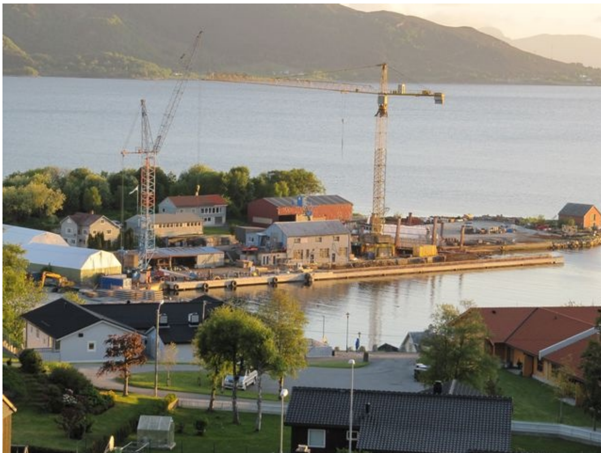
Planområdet sett frå nordaust (Foto: Larsnes Mekaniske Verksted AS, 2009). Sjøbod lengst til høgre er riven.
